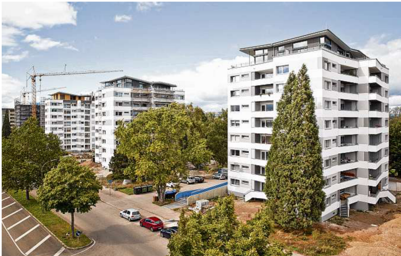
Das sind die fünf achtgeschossigen Hochhäuser in der Überlinger Straße in Singen, die von der Baugenossenschaft Hegau modernisiert wurden. Das Projekt bekam den renommierten Bauherrenpreis. BILDER: HFR
